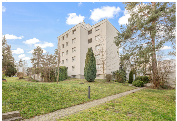
KZO00515 E Einziehen und die tolle Fernsicht geniessen - Aussenansicht Liegenschaft
